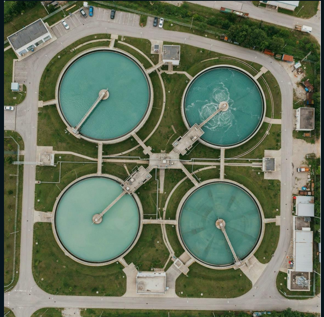
Stations d'épuration des eaux usées, infrastructures techniques associées, distribution HTA/BT et automatismes de conduite.
