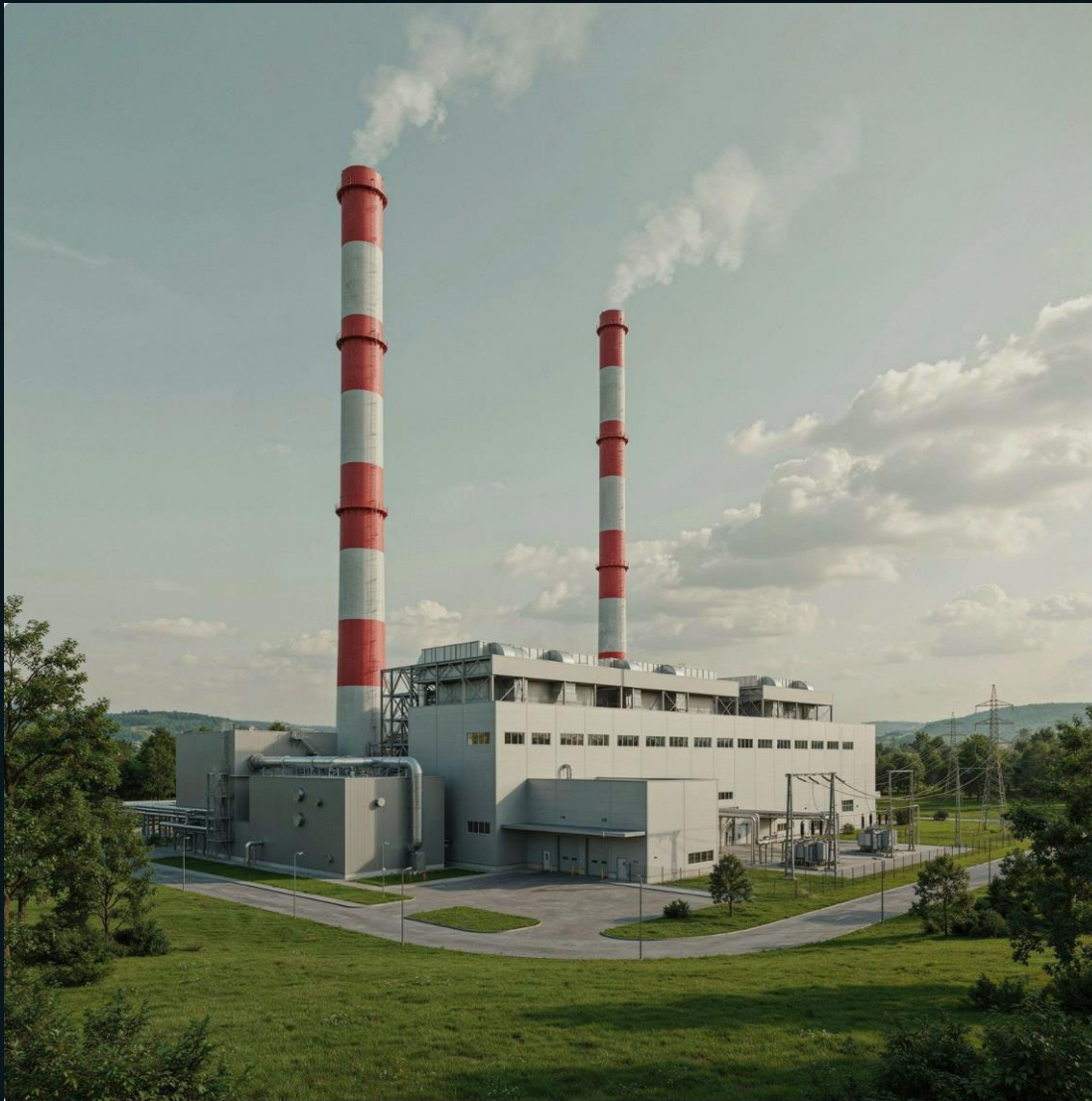
Unités d'incinération des ordures ménagères avec récupération d'énergie et production d'électricité injectée sur le réseau national.
